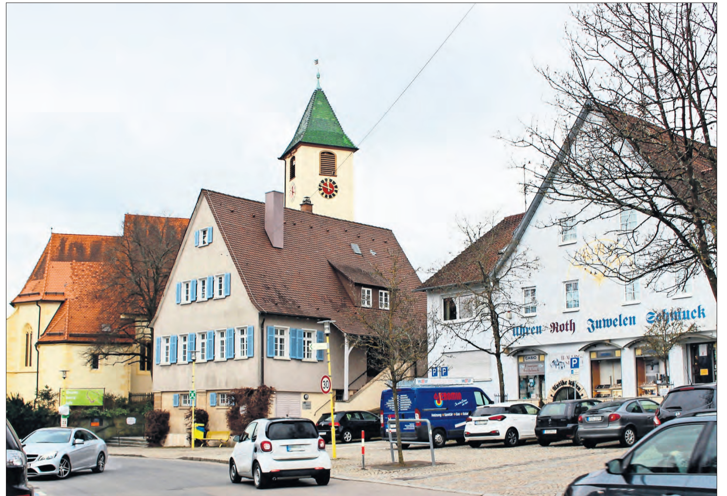
89 Prozent der mehr als 400 untersuchten Gebäude in Plattenhardt weisen Mängel auf.
